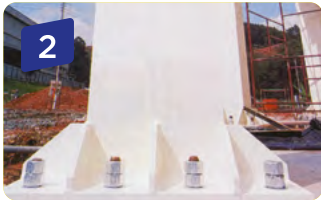
2 ...a montagem de elementos pré-fabricados em betão e de bases de pilares em estruturas metálicas...
