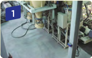
1 O nivelamento e fixação de equipamentos e máquinas...
