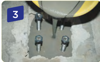
3 ...e a ancoragem de varões ou pernos de ligação entre elementos construtivos são trabalhos delicados e de elevado grau de exigência para os produtos utilizados.
