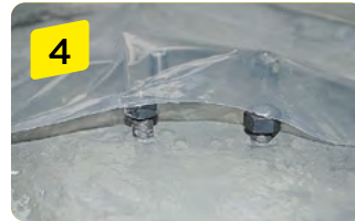
4 Efetuar cura húmida da superfície exposta, molhando frequentemente durante pelo menos 48 horas após a aplicação, para diminuir o risco de fissuração por retração durante o processo de presa.
